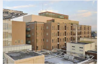
海南病院 外観
