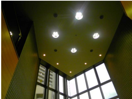
本部棟 玄関風除室吹抜
