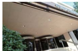
↑ 看護学部棟正面玄関の庇および内部の天井張り替え
